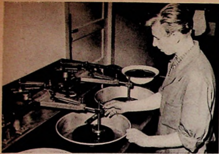
Bild 4. Die Quarzscheibe ist auf einer Pechunterlage befestigt, sie muß beim Schleifen und Polieren ständig feucht gehalten werden (Foto: Telefunken)
